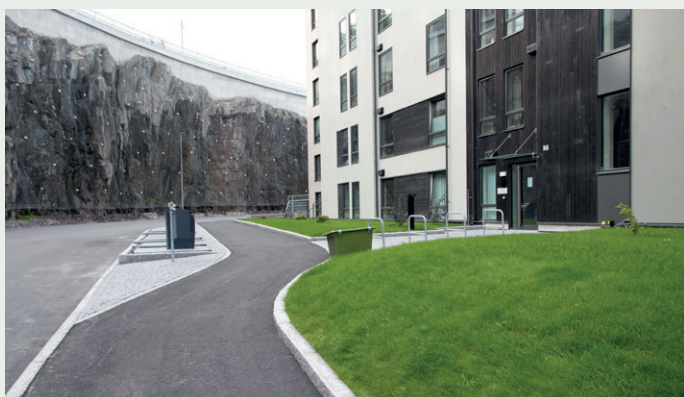
Dronebildet viser omfanget av arbeidet Hersleth har gjort så langt.
